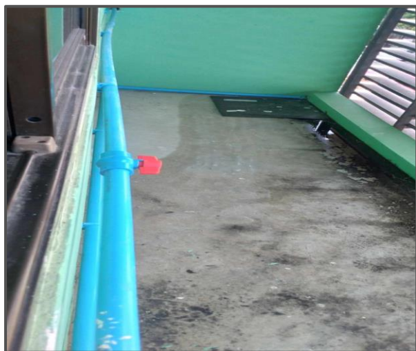
ปรับปรุงระบบท่อน้ำ ห้องเรียนปฏิบัติการบาร์และเครื่องดื่ม 132
