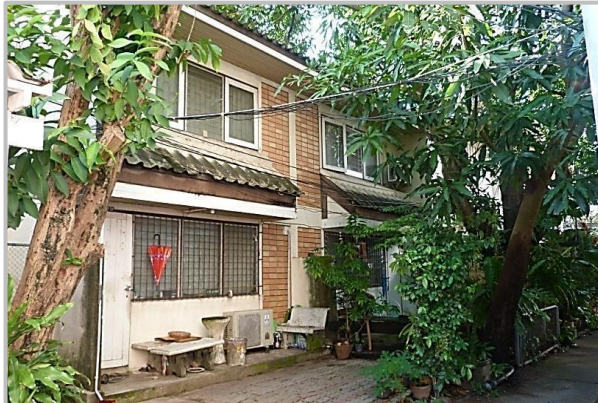
อาคารบ้านพักครู (บ้านแฝด)
